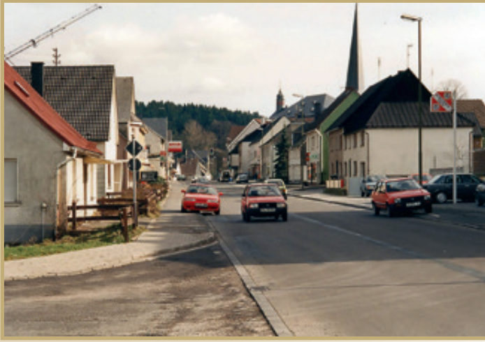
Zum Foto: Die Hauptstraße in Wenden Ende der 80er Jahre. Diverse Teerflicken und „Schotterpisten“ zeigen den Sanierungsbedarf.
